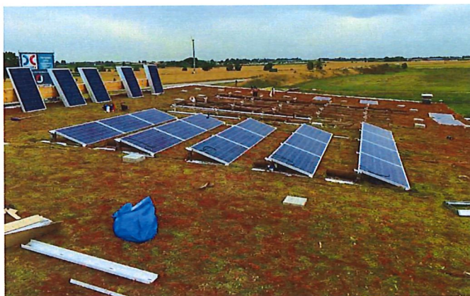
Figur 2 Eksempel på montering. Hentet fra "Solceller på svart, hvit og grønne tak. Energiforsk. Rapport 2017:383"
